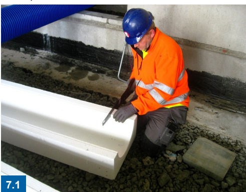
Längdanpassning med fogsvans
