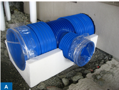
Utskuren isolering för T-kanal
