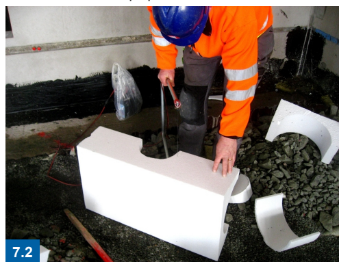
Längdanpassning med cellplastsörare
